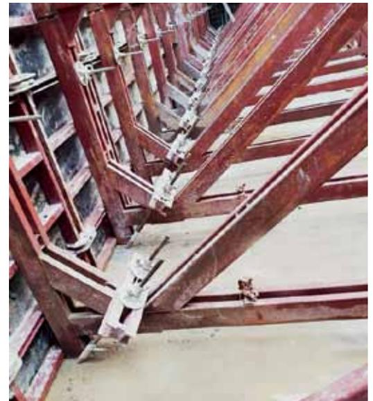
Exemple de voile préparé pour le coulage, avec des écrous à perdre intégrés dans la fondation et des tiges récupérables au premier coulage.
