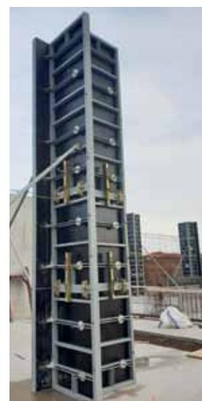
Grâce au pince angle externe et les éléments standards, il est possible de composer des poteaux de différentes dimensions. En respectant la pression maximum de coulage, il est possible de réaliser des compositions sans aucune contrainte de hauteur.
