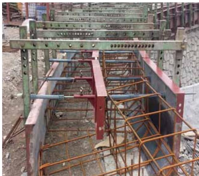
Le coffrage standard BANCHETTONE pour le bordure route correspond à une hauteur de 40 cm et il est réglable de 10 cm de largeur (minimum 60 cm, au maximum 120 cm).
