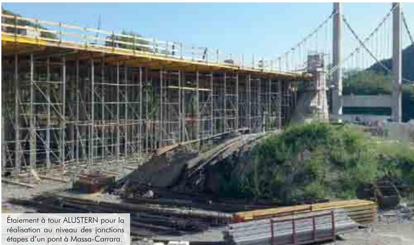
Étaie à tour ALUSTERN pour la réalisation au niveau des jonctions étapes d'un pont à Massa-Carrara.
