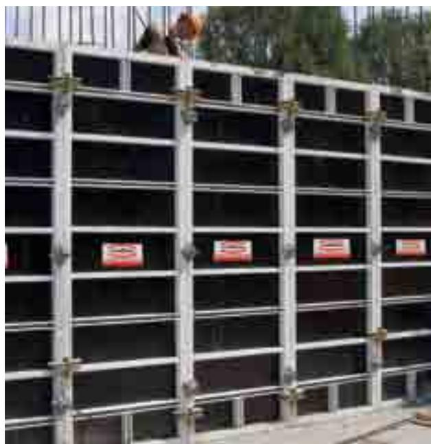
Les éléments standard du système G7000 présents avec deux types de hauteurs (300 et 150 cm) et une largeur de 20 cm à 2 m pour la version en acier.
