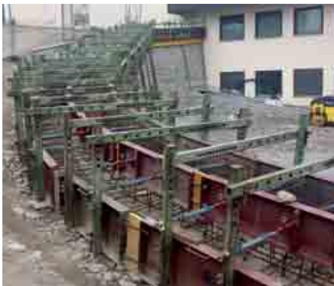
Le coffrage standard pour banchettone, correspond à une hauteur de 40 cm et il est réglable de 10 cm de largeur (minimum 60 cm, au maximum 120 cm).
