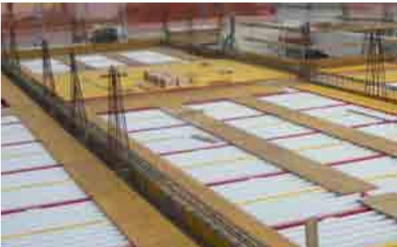
Pour surbaissements supérieurs à 12 cm, il est possible d'utiliser «l'accessoire spécifique pour poutre surbaissée» qui permet de créer des poutres jusqu'à 50 cm.
