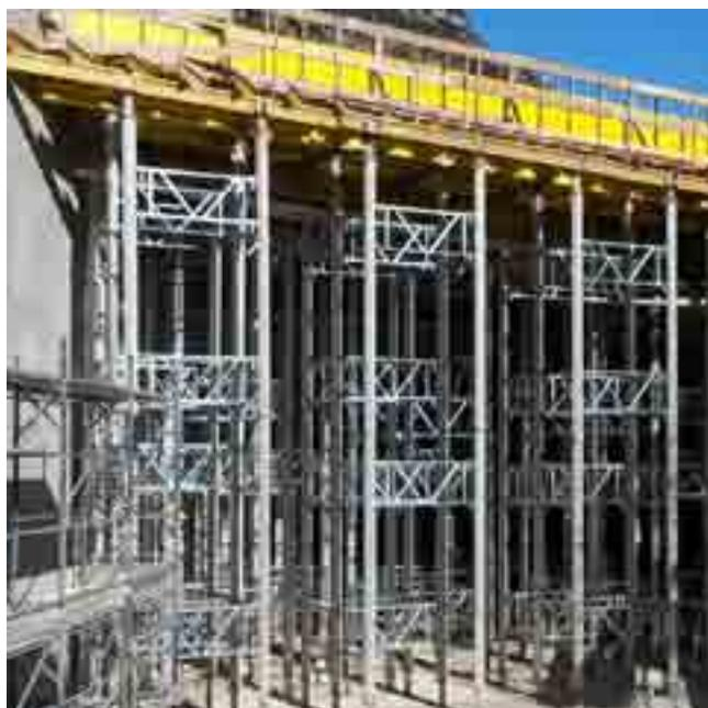
Le profil extérieur spécial des supports permet à un moyen de connexion de châssis cadre, de sorte que le support I-Prop peut être augmentée dans un forme rectangulaire (min. 4 étais) comme une tour de support.
