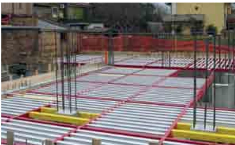
A ce point, où il n'est pas possible de positionner la grille de sécurité, il suffit d'insérer une ou plusieurs poutrelles en bois pour compenser les trous.
