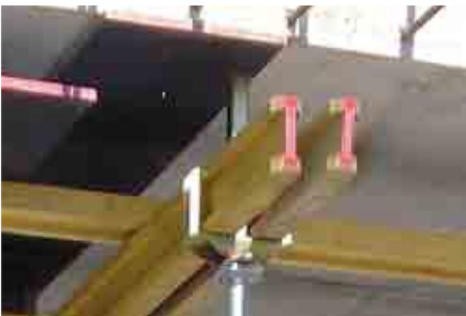
**3. Tête de décoffrage H20** - blocable avec deux boulons sur l'étais EN1065, fonctionnant avec deux poutrelles H20 de poutraison primaire et secondaire, il permet le décoffrage partiel ou bien récupération de H20 et 75% des panneaux coffrants, laissant les étais et les têtes de décoffrage à l'appui de la dalle.
