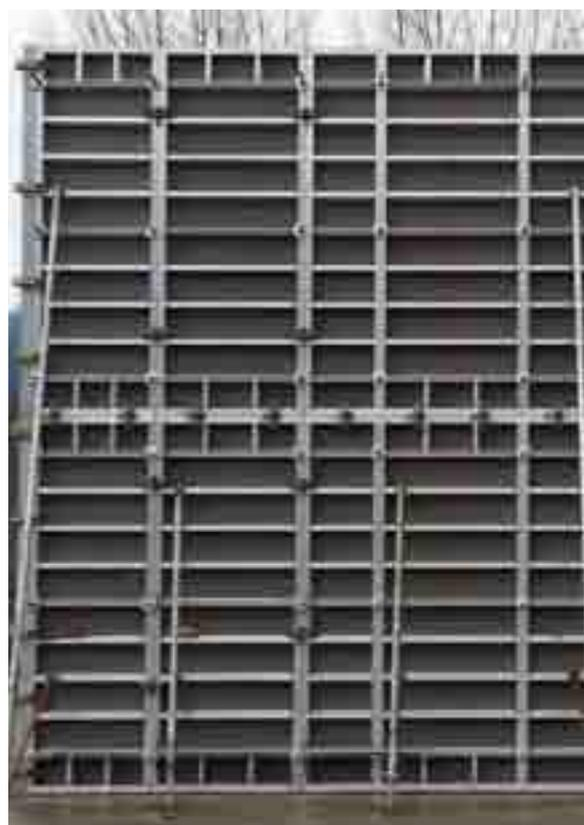
Les éléments, avec des dimensions optimisées pour le transport, hauteur 3 m et 1,2 m, peuvent être combinés avec des accessoires simples et fonctionnels qui permettront au système I-Form d'avoir une modularité unique en son genre.
