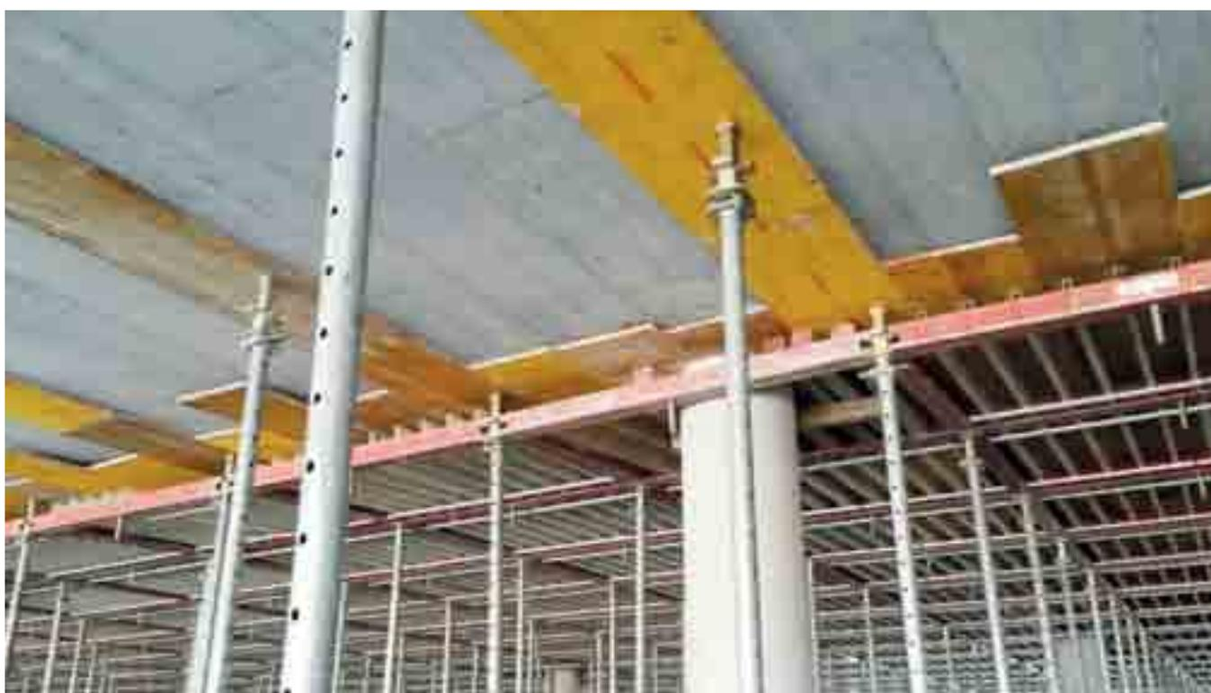
Une fois les composants du plan horizontal récupérés, il suffira de disposer d'une deuxième dotation d'étais et de têtes de décoffrage pour permettre une réutilisation immédiate.
