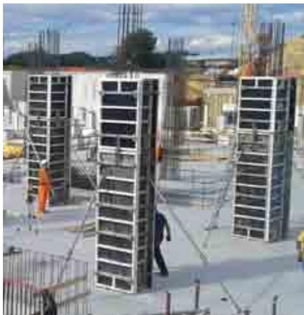
Grâce au pince angle externe et les éléments standards, il est possible de composer des poteaux de différentes dimensions. En respectant la pression maximum de coulage, il est possible de réaliser des compositions sans aucune contrainte de hauteur.
