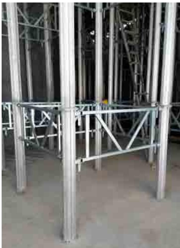
Les étais I-Prop peuvent être augmentés et encadrés. La fixation de la barrière est réalisée au moyen de la clavette de blocage.
