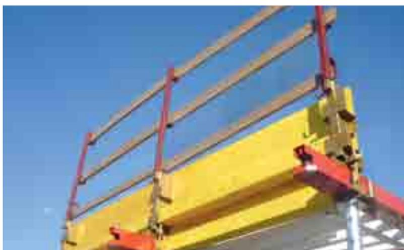
3) Des „lèvres fermeture avec garde-corps“, monté sur à l'un des poutres du système.
