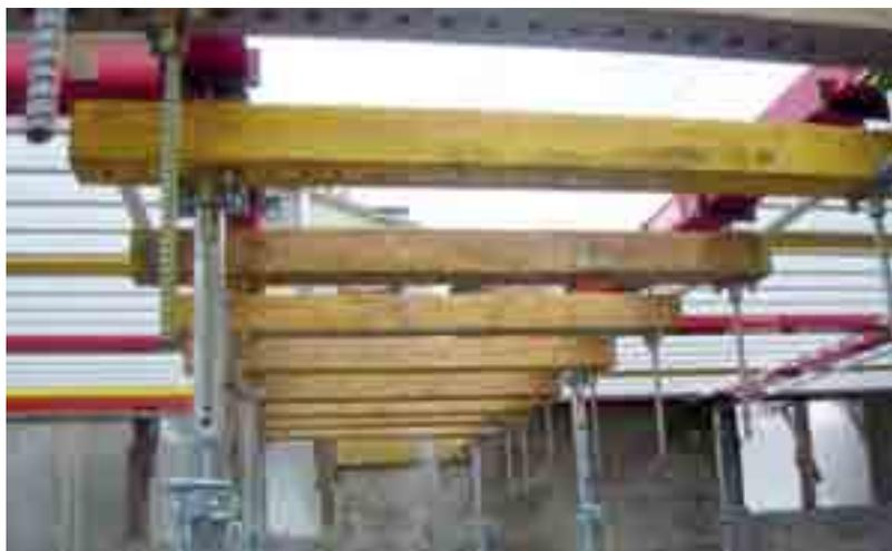
1) „Accessoire pour poutres“ rabaissées qui permet des abaissments de poutres jusqu'à 50 cm de hauteur.
