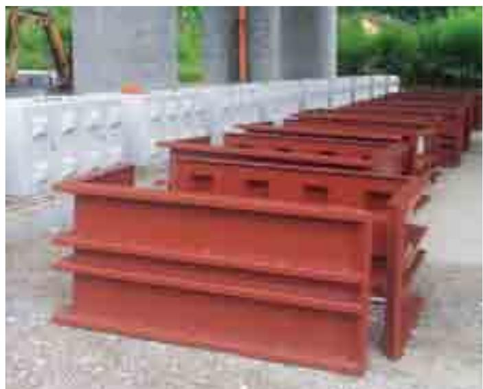
I-Block peut être déplacé au moyen de crochets de levage appropriés (les crochets de levage sont les mêmes avec lesquels il déplace l'objet en béton terminé), pouvant être fixée sur les ongles de levage disposés sur les quatre coins du coffrage.
