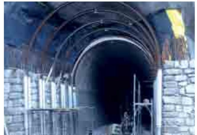
Support avec de poutrelles calandrés en acier et étais en Alu pour la rénovation du tunnel
