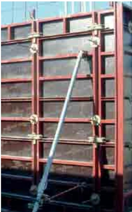
Le système MAXIM est constitué d'accessoires simples et fonctionnels qui permettent à l'opérateur de relier, de fermer ou d'effectuer toute opération nécessaire.
