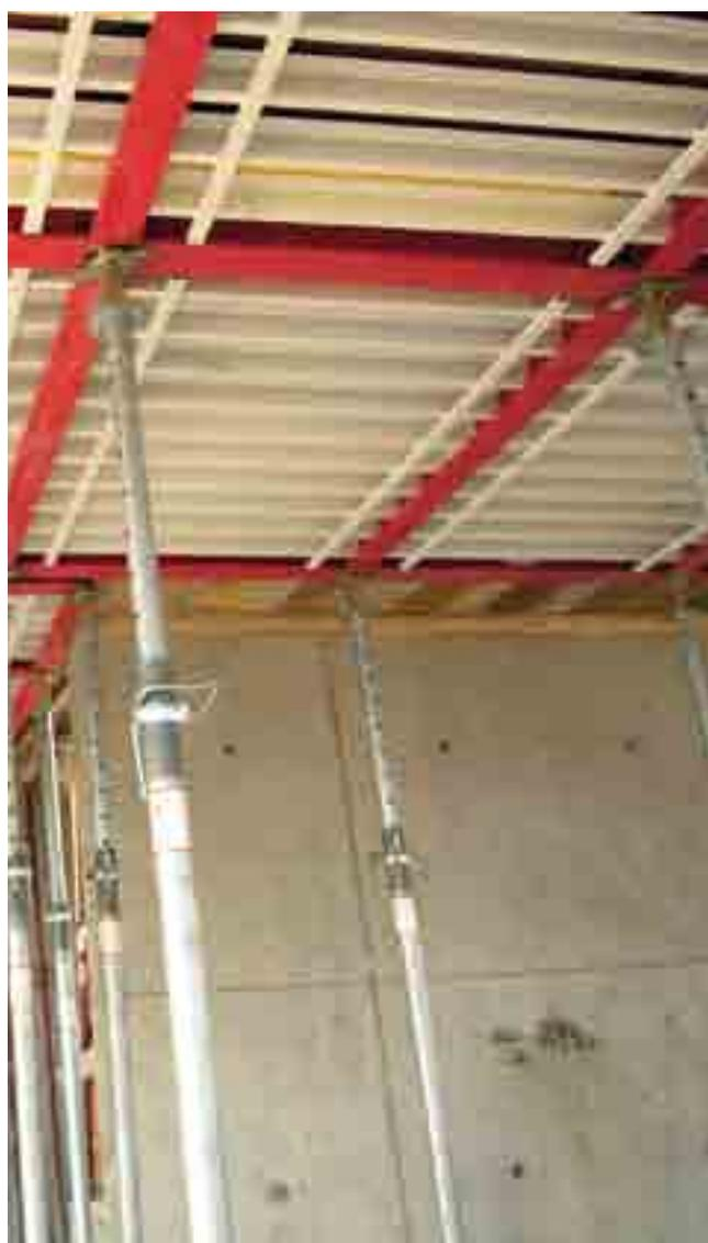
Le système VELOX se compose essentiellement de 5 éléments : étau, tête de décoffrage, poutres portantes, grille de sécurité et/ou poutrelle laminée.
