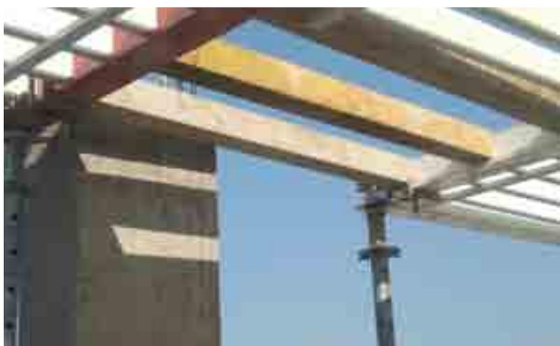
2) „Accessoire de connexion universel“, avec lequel il est possible de réaliser des saillies et des connexions intermédiaires en absence de poutres.
