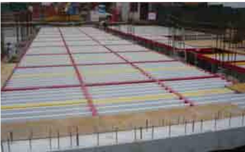
On interromp la formation des maillages à proximité de la poutre et on crée le support avec une rangée de maillages surbaissée et on repart avec le coffrage. Il est possible d'effectuer cette même opération de manière traditionnelle.
