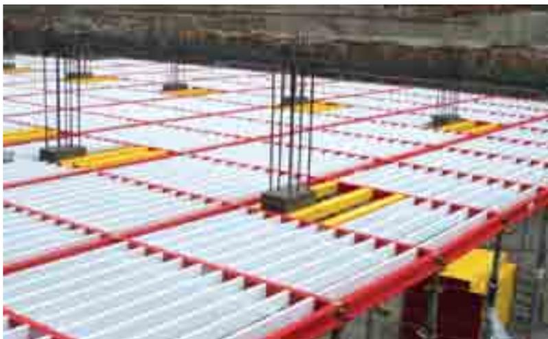
Avec la formation de modules rectangulaires ou carrés de différentes dimensions, VELOX est un système extrêmement flexible, en mesure de garantir le maximum de couverture, même en présence de dalle géométriquement complexes.
