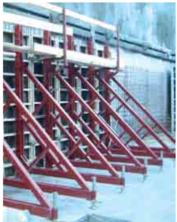
Le système de PAT, combinée aux éléments de coffrage, permettent de coffrer de manière simple et rapide, paroi simple (monoface). Les forces dues au bétonnage est déchargé à travers la structure dans les écrous à perdre précédemment placé dans la fondation. Le système de PAT peut être combiné avec le système de coffrage MAXIM, G7000, ORBIS et tout autre coffrage sur le marché.
