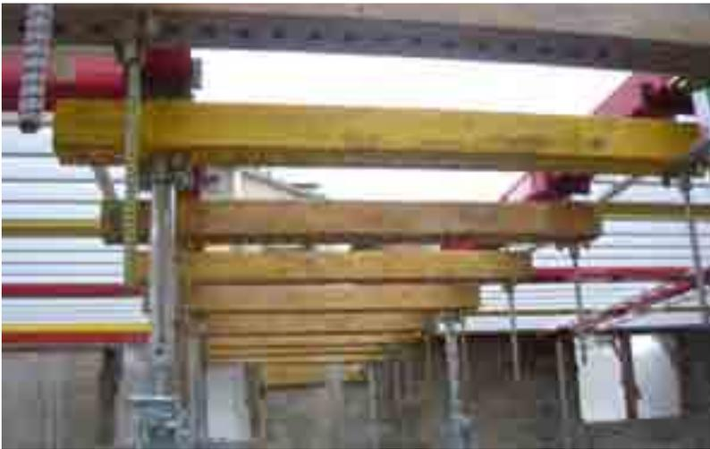
Pour surbaissements jusqu'à un max. de 12 cm, la solution consiste à interrompre la formation des maillages au niveau de la poutre et à créer une „poche“ d'un maillage à l'autre à l'aide d'un support coulissant.
