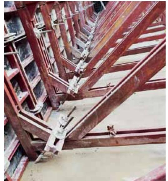
Beispiel: Verankerung für seitige Schalung, verlorene Sechskantmutter im Fundament verankert und in Verbindung mit Gewindestab und PVC-Rohr.
