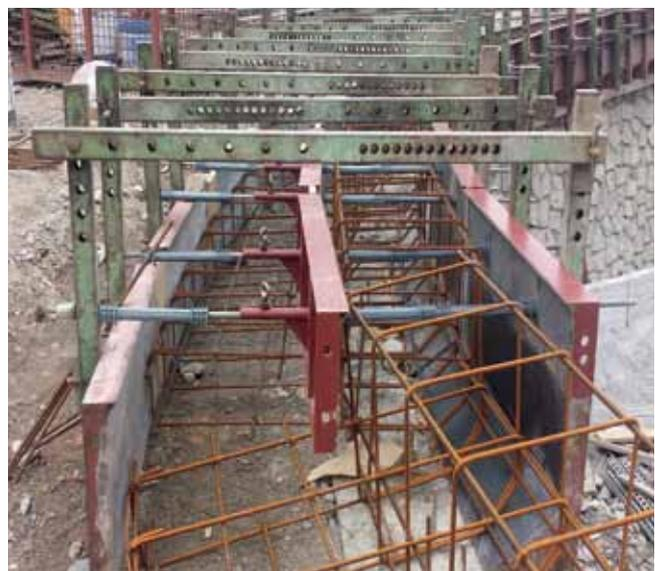
Die **Standard-Schalung** für Betonkranz hat eine Höhe von 40 cm und ist in der Breite alle 10 cm verstellbar (min. 60 cm - max. 120 cm).
