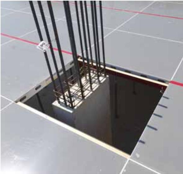
Die Träger UNI werden am Stützenkopf eingelegt und bilden so die Auflagefläche für alle Passbereiche. Mit dem Träger UNI kann ein Ausgleichen an Wänden, Pfeilern oder abgesenkten Trägern sehr einfach ausgeführt werden.
