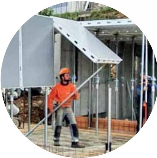
Die Elemente bestehen aus pulverbeschichteten Aluminiumprofilen RAL9010. Die Schalhaut besteht aus einer 9 mm starken Vielschichtplatte mit Phenolharzfilm 220 g/m<sup>2</sup>.
