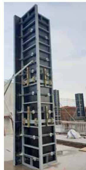
In Kombination mit Standard-Elementen und den Ausseneckklemmen können Säulen in verschiedenen Größen geschalt werden. Mit Berücksichtigung des maximalen Betondruckes können Säulen auch ohne Höheneinschränkung realisiert werden.
