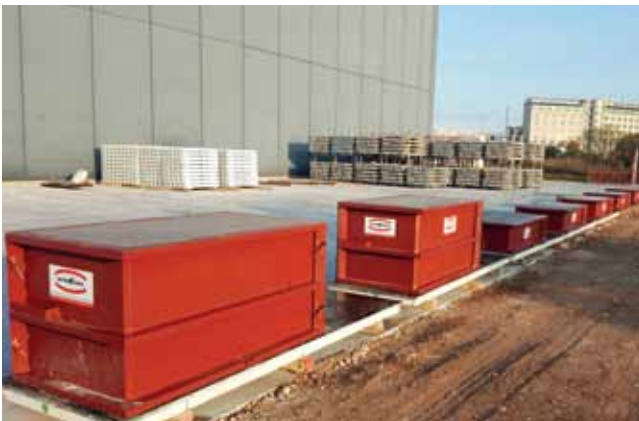
I blocchi di cls. possono essere costruiti direttamente in cantiere o nel magazzino.
