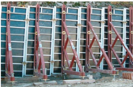
Tragende Wände (einseitiges Schalen)
