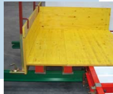
Ausgleich mit Schalungsträger und Abschalwinkel
